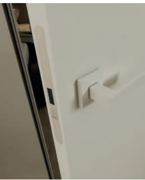
ZAMEK AGB Z BEŻOWĄ NAKŁADKĄ, SZARA BLACHA ZACZEPOWA
