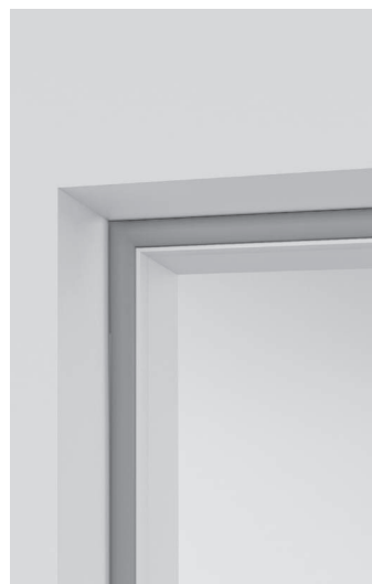
OŚCIEŻNICA PRZYGOTOWANA DO MALOWANIA FARBĄ ŚCIENNĄ, SZARA USZCZELKA
