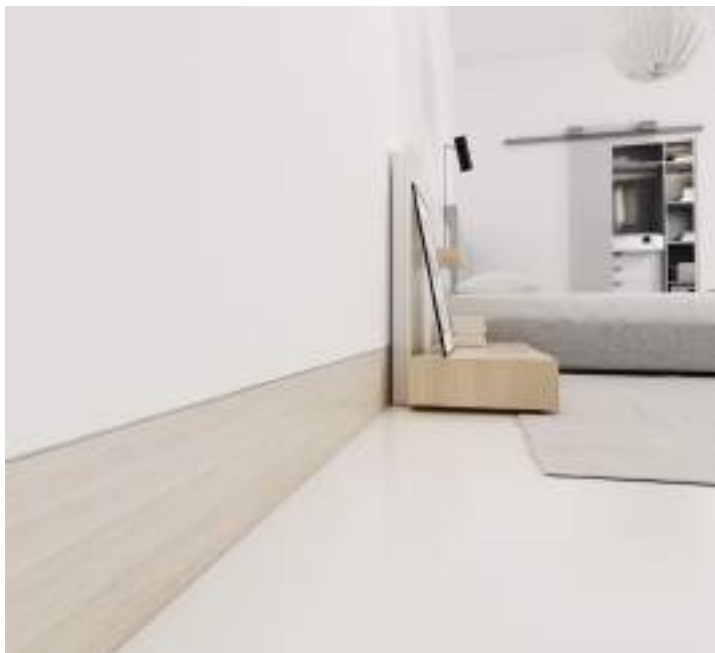
LISTWA COKOŁOWA ZLICOWANA ZE ŚCIANĄ LC02-MDF10, FORNIR DĄB BIELONY FLUSHED WITH THE WALL SKIRTING BOARD LC02-MDF10, VENEER BLEACHED OAK
